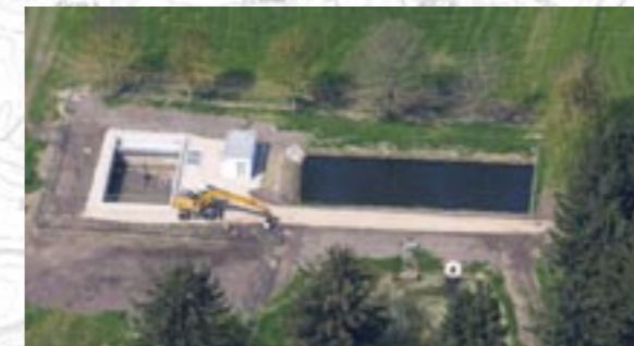
Luftaufnahme Pumpstation und Regenüberlaufbecken
