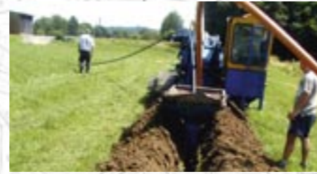
Verlegung der Leitungen zwischen den Ortsteilen
