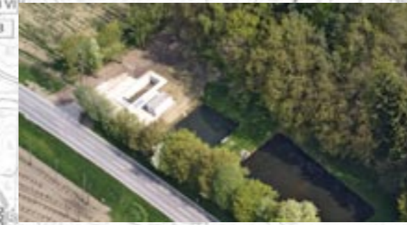
Luftaufnahme Pumpstation und Regenüberlaufbecken
