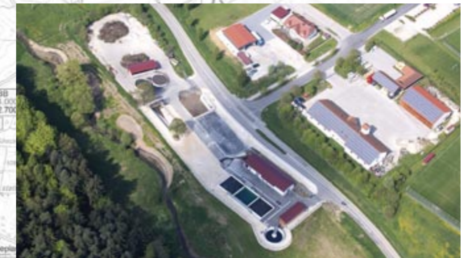
Luftaufnahme neue Kläranlage Gerolsbach
