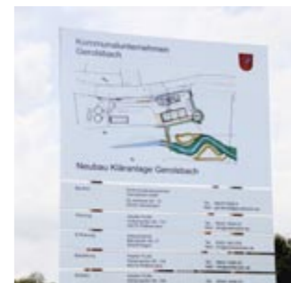
Dezember 2011 Baubeginn des neuen Betriebsgebäudes, Nachklärbeckens und Belebungsbeckens.
