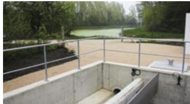
Regenüberlaufbecken mit Blick auf Schönungsteich (ehemaliger Klärteich)
