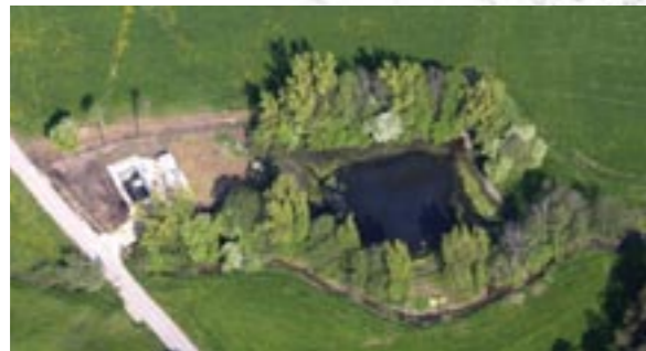
Luftaufnahme Pumpstation und Regenüberlaufbecken
