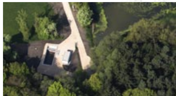
Luftaufnahme Pumpstation und Regenüberlaufbecken
