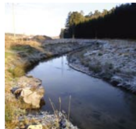
Mai 2011 Baubeginn mit der Verlegung des Gerolsbaches.
